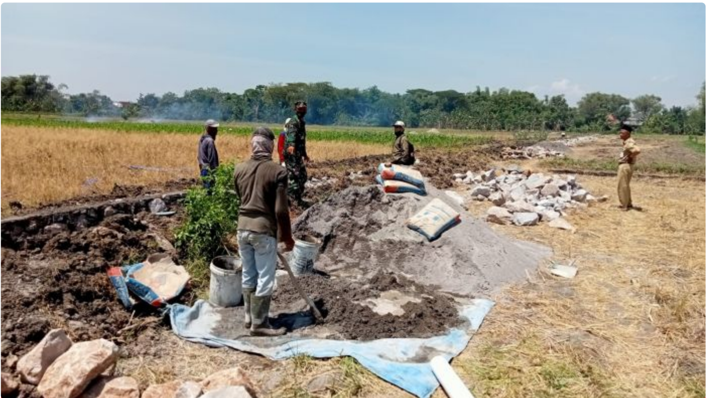
Giat Babinsa dan Kades Temuroso Pantau Pembangunan Irigasi Persawahan
